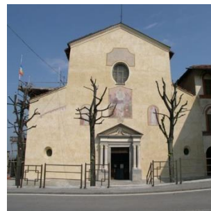
Chiesa di San Bernardino a Saluzzo (Cn): restauro della facciata
