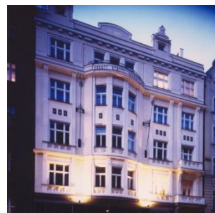
Praga, Repubblica Ceca, ristrutturazione palazzo in via Vezenska 5
